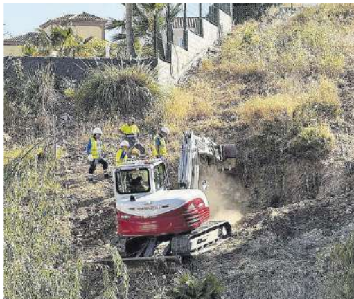
Operarios de Acosol trabajan en la reparación de la tubería de Benalmádena.
