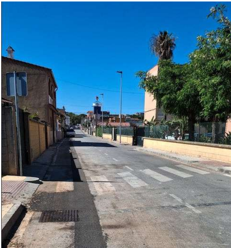
Emalgesa continúa con la renovación de la red de abastecimiento en las calles Mirlo y Codorniz.
